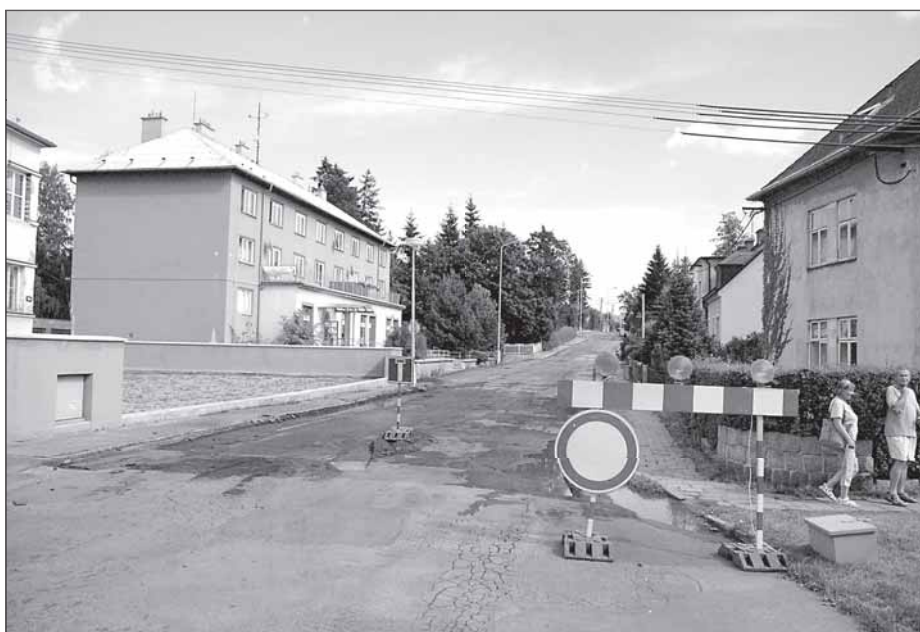
Husova ulice je z důvodu opravy pro dopravu uzavřena.
