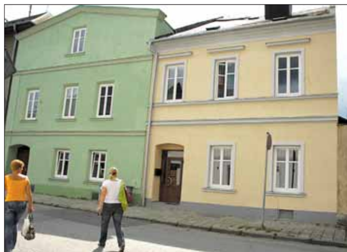
Opravená fasáda sídla Hospodářské správy v ulici Požárníků.
