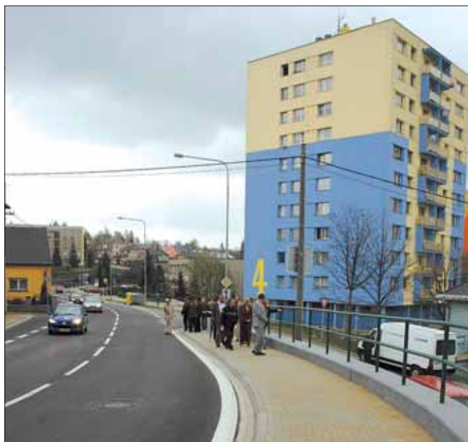
Zahradní ulice po celkové rekonstrukci v délce 431 metrů slouží dopravnímu provozu.
