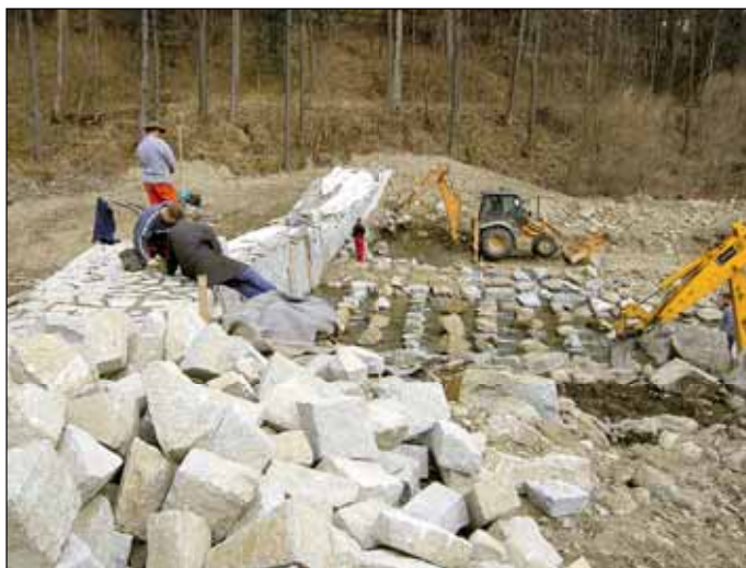
Protipovodňová opatření na Vrbensku budou dokončena letos.
