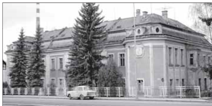
Budovy soudu i bývalé věznice budou rekonstruovány Foto: -dd-
