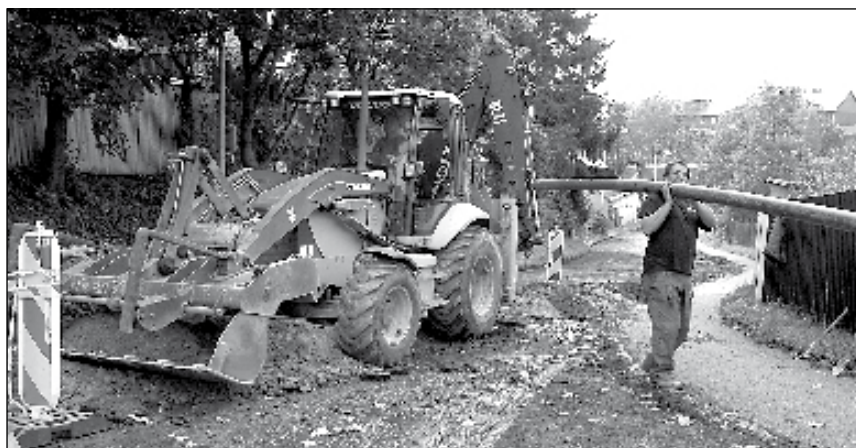
Počasí přeje stavebním pracím. Na snímku oprava kanalizace při rekonstrukci silnice na Žlutém kopci pod viaduktem. Foto: -dd-
