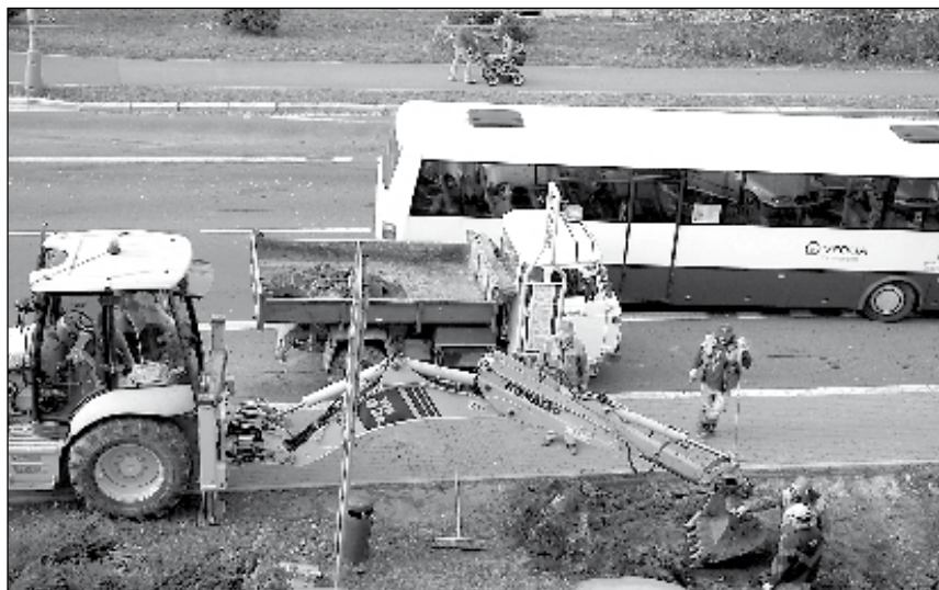
Pracovníci Technických služeb Bruntál začali budovat základy pro přístřešky na sedmi autobusových zastávkách ve městě. Foto: -dd-
