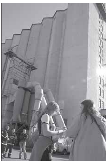
Budova sila a účastníci běhu, kteří se nebáli zdolat 230 schodů na čas.
