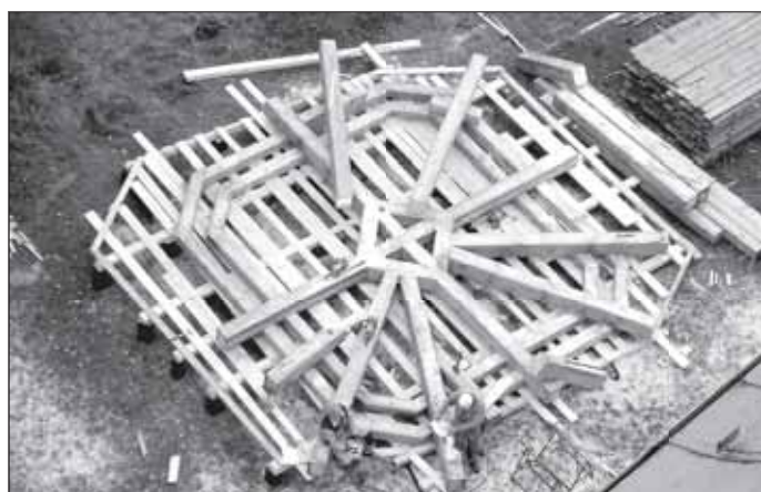
Po dokončení odborných tesařských prací a kompletaci jednotlivých krovových částí, bude věž vyzdvížena jeřábem na zděnou stavbu, mělo by to být 24. října.
