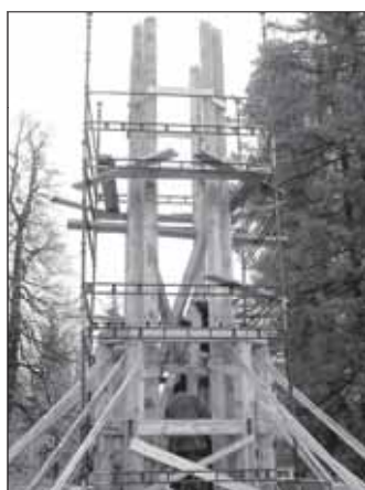
Práce na nové věži byly zahájeny okamžitě po demontáži věže staré.
