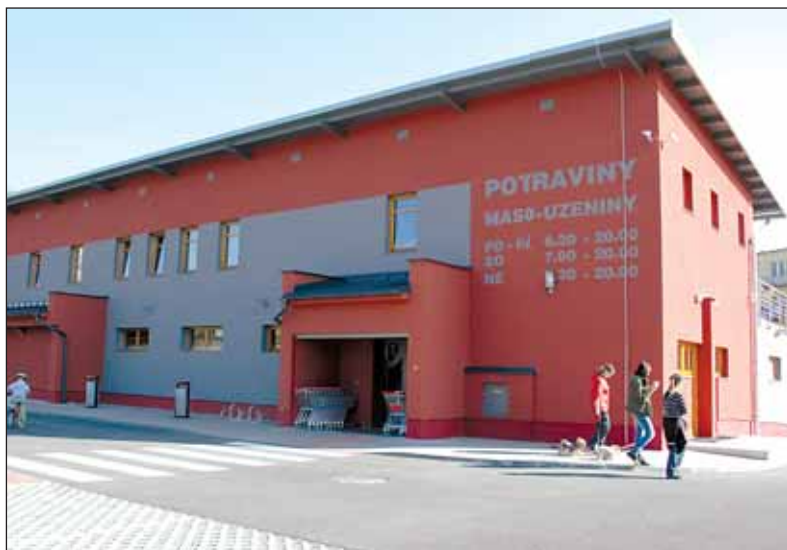
Přístavba budovy prodejny o jedno patro a její nová fasáda daly moderní nádech části města v Rýmařovské ulici.
