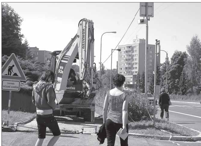
Oprava chodníku v Nádražní ulici si vyžádá dočasné omezení pro chodce.
