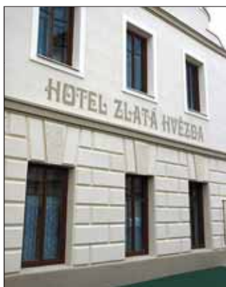
Hotel Zlatá hvězda zdobí nová fasáda. Více na str. 6
