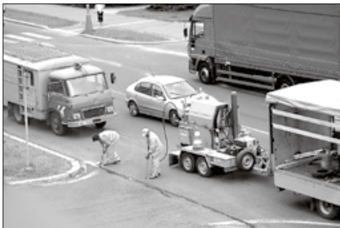
Opravy se v minulých dnech dočkala také průjezdová komunikace městem. Foto: -dd-
