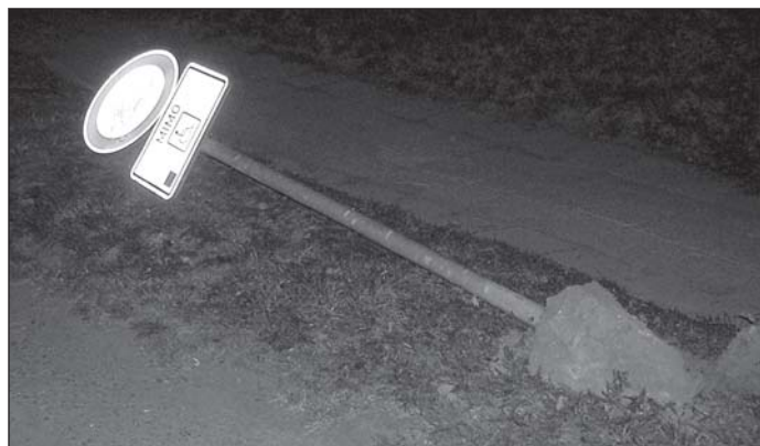
Na dvou místech našli strážníci městské policie 11. dubna vyvrácené dopravní značky - na ulicích Květné a V Aleji. Poškozené značení zdokumentovali a nahlásili správě majetku města.
