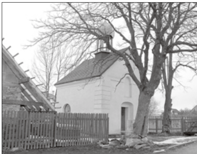
Současný stav renovované kaple v horní části Razové.
