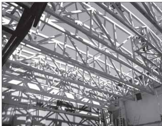
Položení základů nové střechy stihli řemeslníci ještě před příchodem sněhu.
