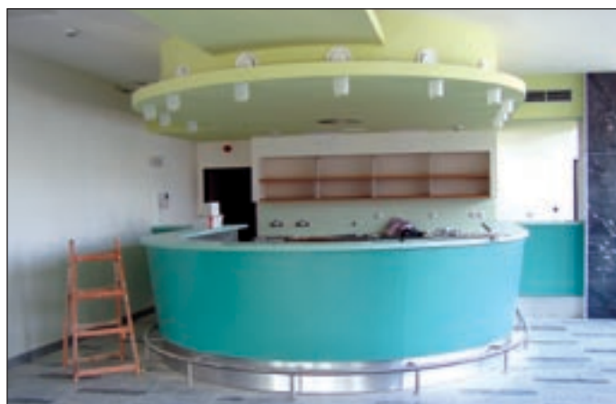
V prvním patře přístavby je bar.
