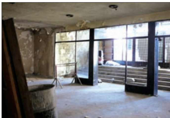
Interiér vstupní části.
