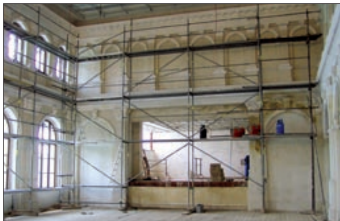
Pohled do hlavního sálu v průběhu oprav.
