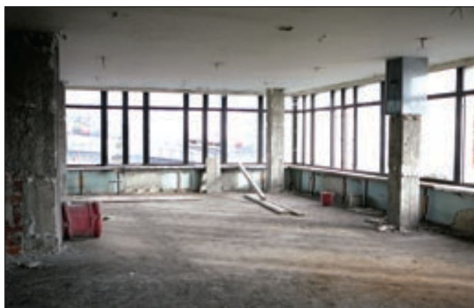
Prostory přístavby před rekonstrukcí.
