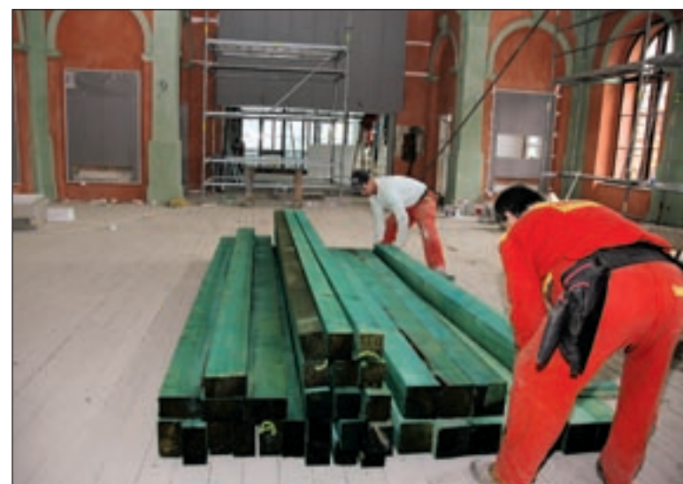
Práce v interiéru.
