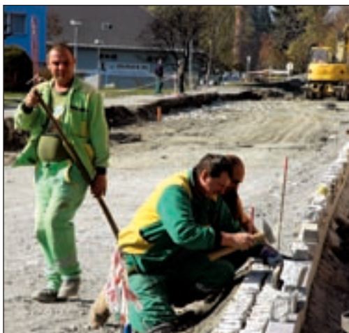
Zahradní ulice prochází v těchto dnech rozsáhlou opravou. Stavebním pracem přeje počasí. Foto: -dd-
