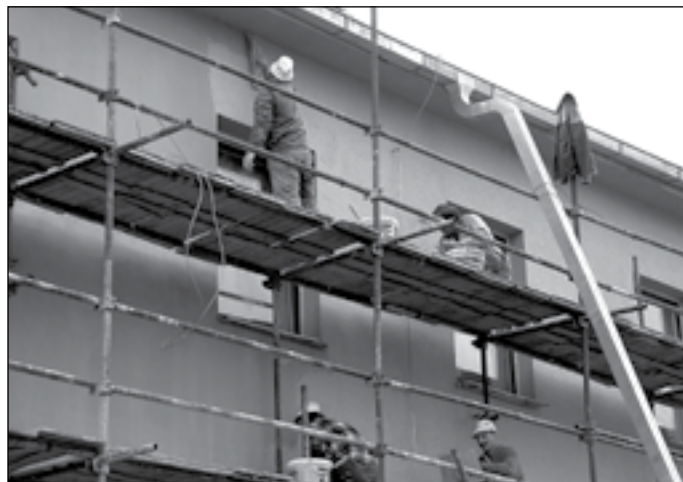
Na dokončovacích pracích ve Společenském domě pracuje zhruba osmdesát řemeslníků různých profesí. Fasáda už je téměř kompletně hotová. Fota: -dd-
