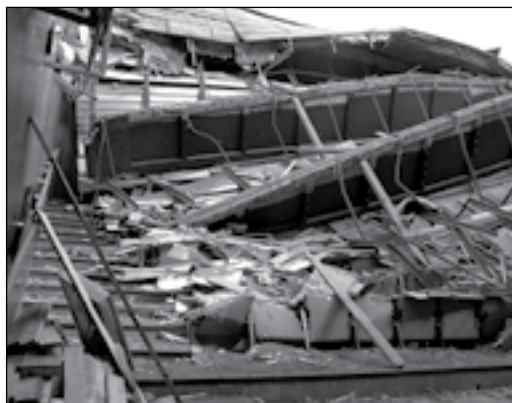
Celá střecha je odklizená po částech. Fota: -dd-
