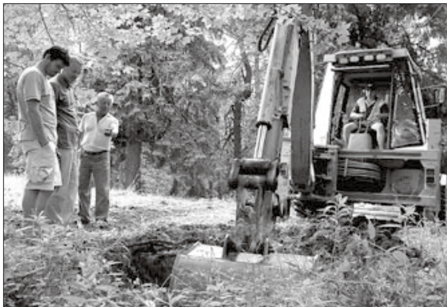
Poprvé se bagr zaryl do země na Velkém Roudném 13. června. Základní kámen nové rozhledny bude posvěcen při slavnostní Petropavlovské pouti 1. července v 11 hodin.
