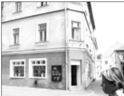
Rohový dům bývalého hotelu Hruška bude mít novou fasádu. Foto Petra Štulová
