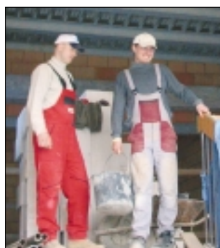
Dělníci na stavbě operačních sálů v nemocnici. Foto -dd-
