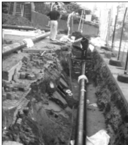
Rekonstrukce rozvodů tepla a budovy městského úřadu. Foto - dd-
