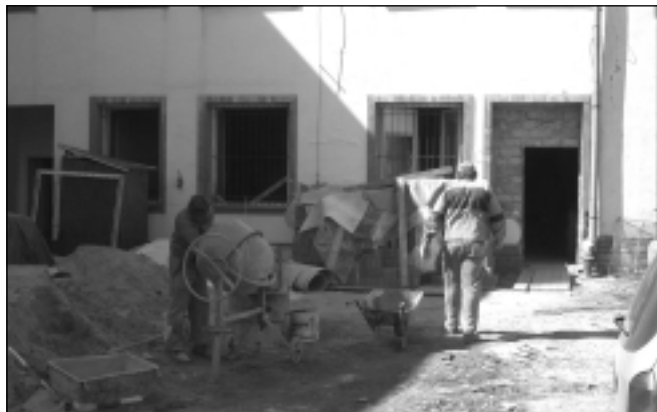
Bývalou radnici v centru města čeká letos kompletní rekonstrukce.
