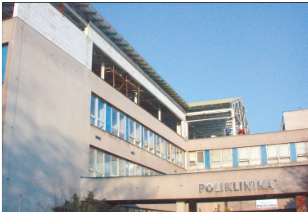
Hrubá stavba budoucích operačních sálů v nemocnici vyrostla na budově polikliniky během zimy.
