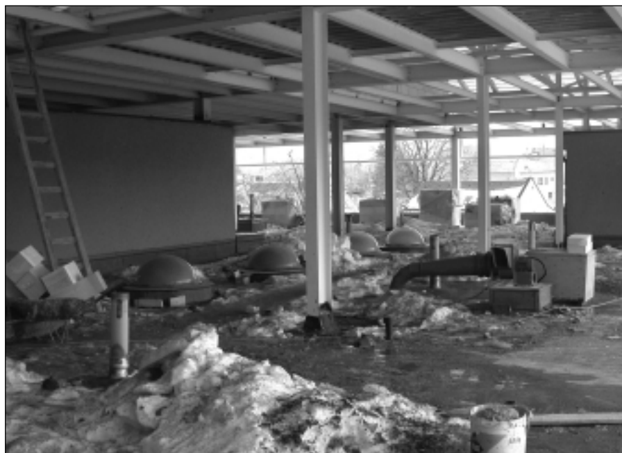
V těchto místech budou operační sály bruntálské nemocnice.
