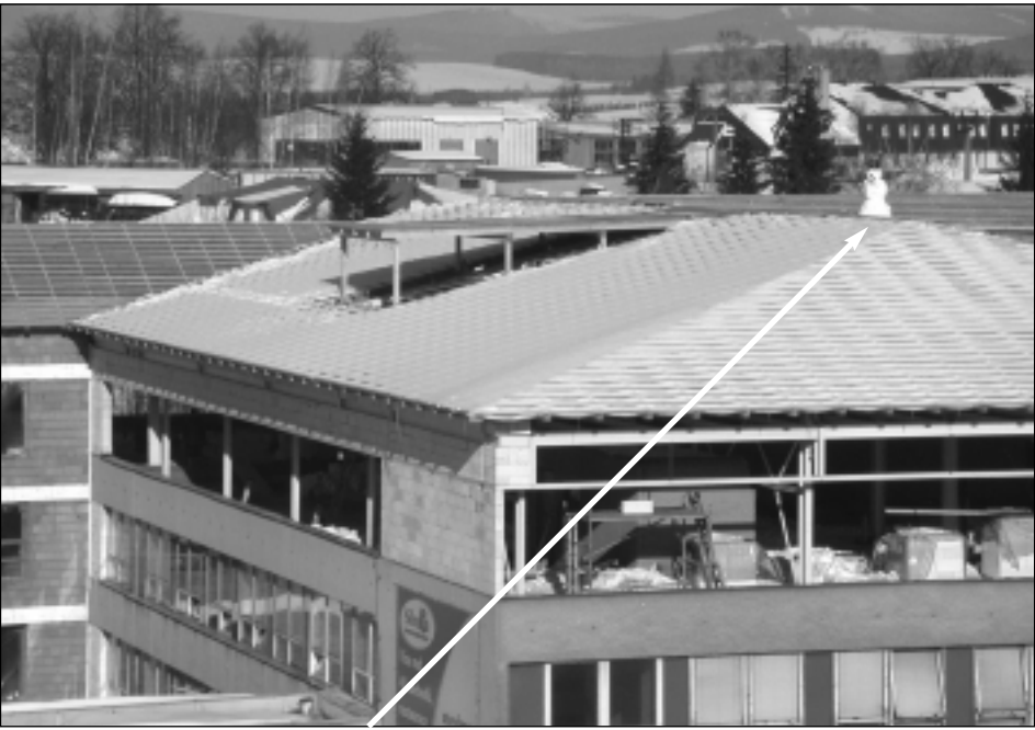
Na dokončené střeše budoucích operačních sálů byl k vidění místo tradiční májky sněhulák.
