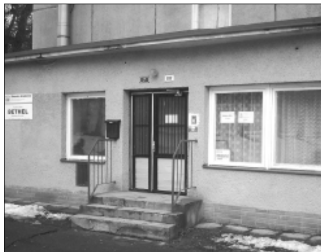
Azylový dům vznikl z dřívějšího internátu průmyslové školy. Nyní slouží lidem bez vlastní střechy nad hlavou.
