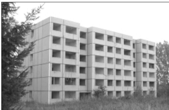
Některé objekty v Západní lokalitě vypadají opravdu nevábne.
