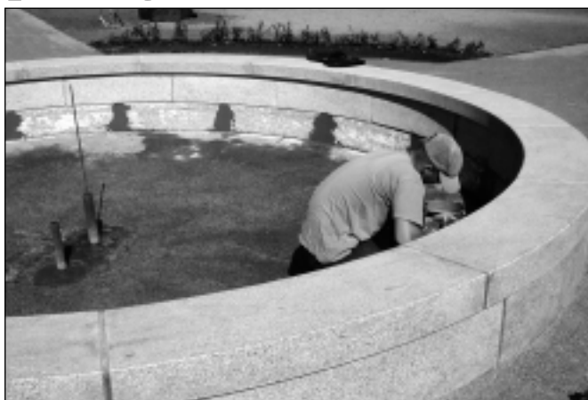
Zámecké náměstí bude po rekonstrukci ukrývat také schránku pro budoucí generace. Na snímku obnova kašny. Foto - mon-
