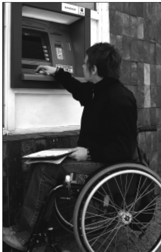
Typický příklad nedodržení stavební vyhlášky: oči vozíčkáře jsou v úrovni tlačítek na bankomatu, takže člověk ani nevidí, co mačká.
