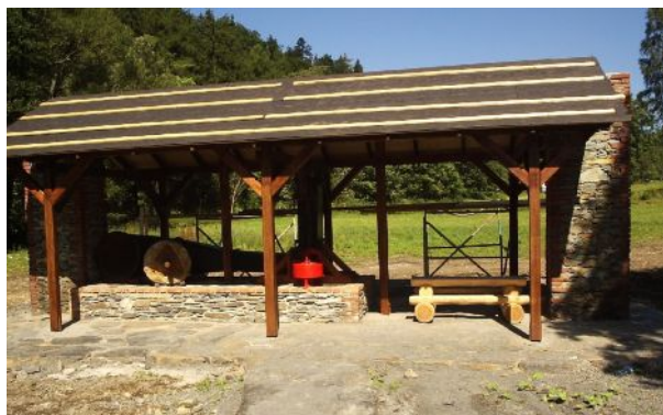
Zastavení u technické památky před dokončením
