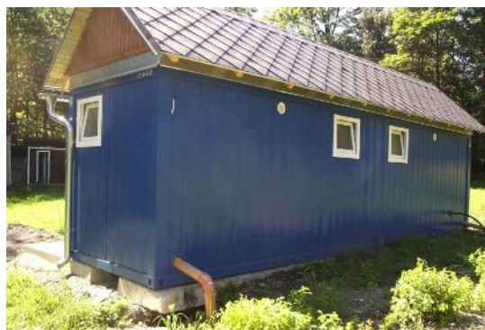
Nové sociální zařízení na tábořišti v Karlově
