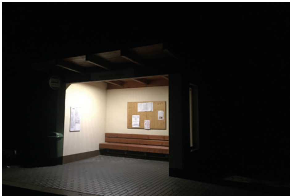
Solární osvětlení zastávek – vlastní zdroje 221 316 Kč
