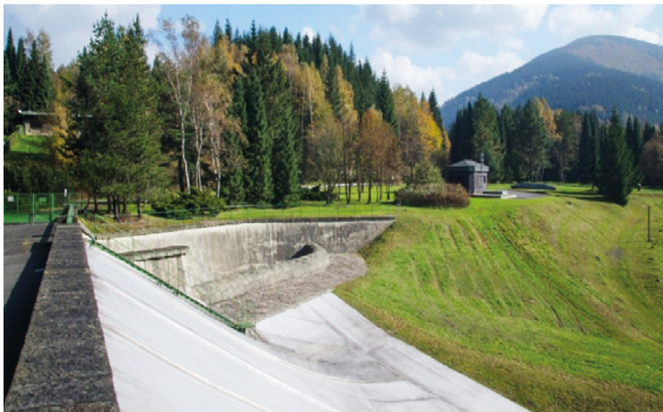
Obr.6 Současný stav spadiště a přelivu
