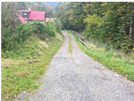
Komunikace před opravou
