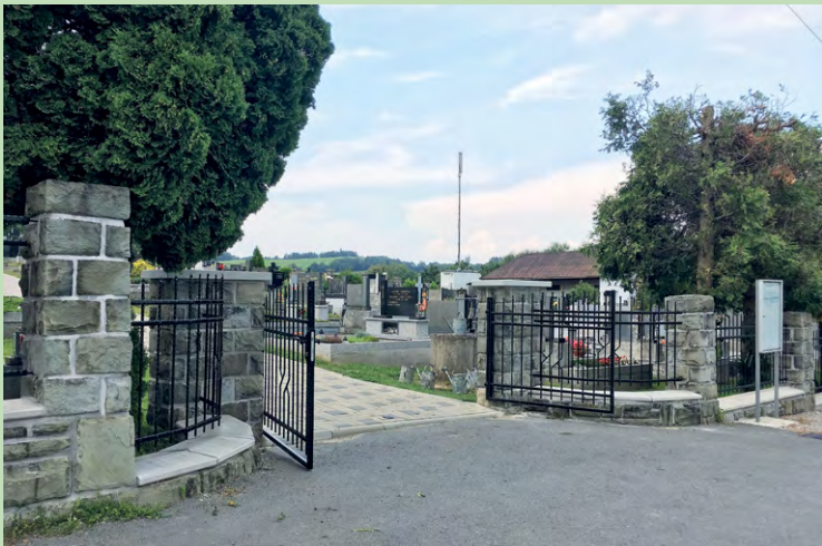
Obec ukončila rekonstrukci hřbitova. Opraveny jsou hřbitovní zdičky, byla provedena výměna plotových rámků a vstupních bran – druhá etapa.
