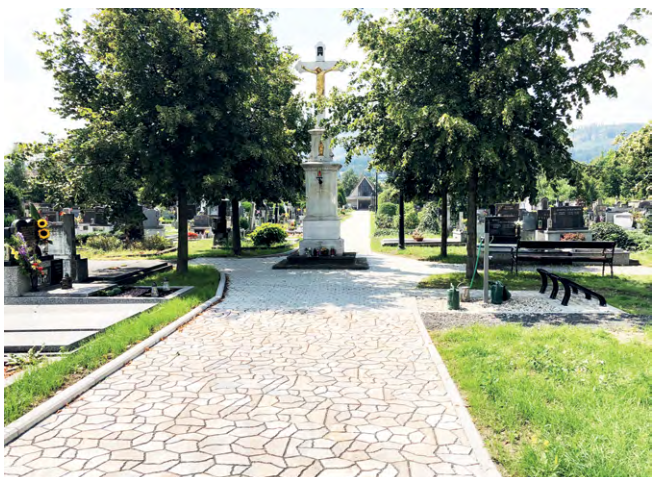
Rekonstrukce chodníků na hřbitově, oprava plochy před smuteční obřadní síní, vybudování osvětlení, úprava rozvodu vody. Cena díla 3,5 mil. Kč (realizováno z vlastních zdrojů).
