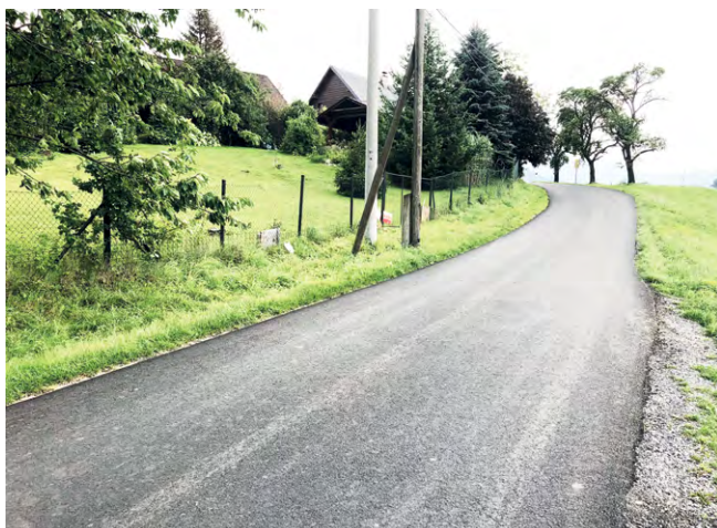
Oprava povrchu části komunikace Lubno (Tutto směr Malenovice), po vypořádání majetkových poměrů dojde k realizaci další zbylé části.
