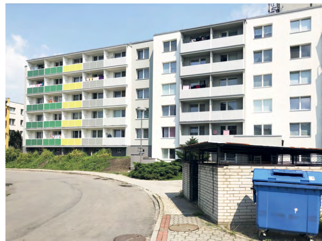
Zateplení bytového domu pro seniory (DPS) na ulici Pionýrů, výměna oken a oprava balkonů. Cena díla 10,7 mil. Kč (30% dotace IROP).
