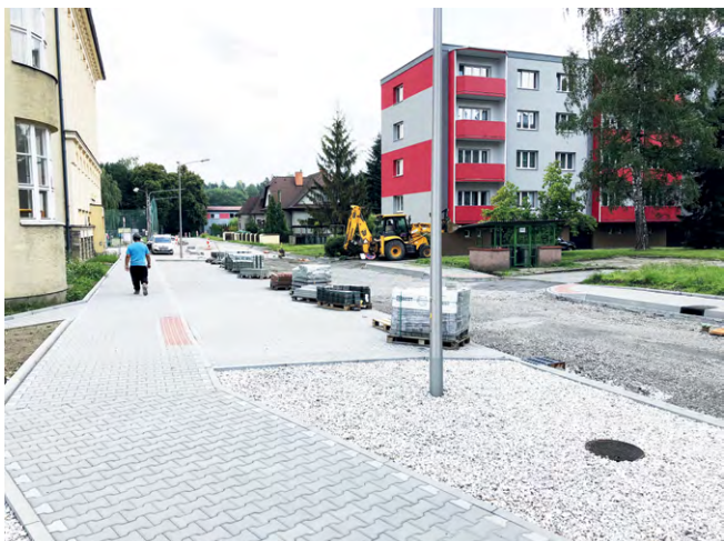
Generální oprava komunikace na ul. Komenského včetně přeložek kanalizace, veřejného osvětlení a dalších sítí. Cena díla 7,5 mil. Kč (z vlastních zdrojů).
