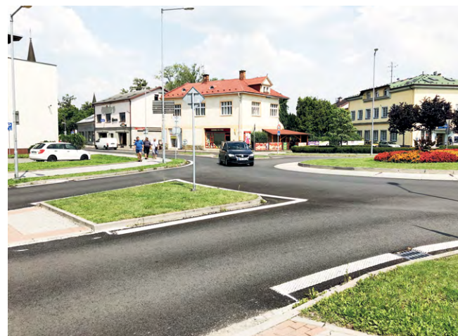
Rekonstrukce povrchu komunikace průtahu městem od Nové Dědiny po Přžno. Investorem je Moravskoslezský kraj. K úpravě kanálů, sjezdů apod. dojde po vyasfaltování problémových úseků v Přzně a Bašce.
