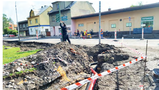
Rekonstrukce křižovatky u kolejí vč. části ul. Poštovní se zřízením autobusových zálivů, II. etapa. Investorem je Moravskoslezský kraj společně s městem. Cena díla za obě etapy 15 mil. Kč.
