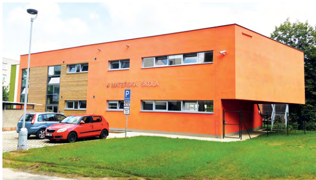
Přístavba Mateřské školy Janáčkova, kde od září bude nový prostor pro 50 dětí. Součástí stavby je i vnitřní vybavení a venkovní hrací prvky. Celková hodnota díla 17,5 mil. Kč (90% dotace IROP).
