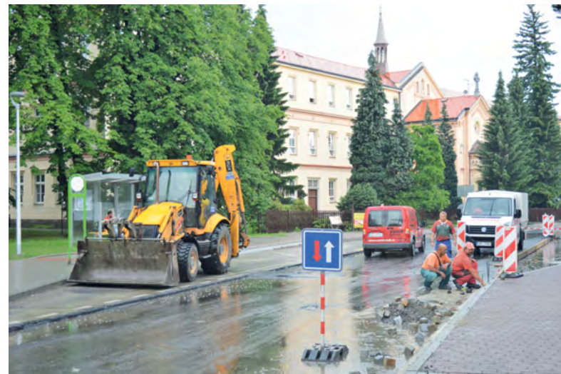
REKONSTRUKCE VOZOVKY: Projít ulici Hlavní chce trochu trpělivosti a spoustu pozornosti. Foto: Petr Pavelka
