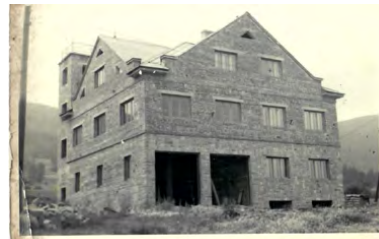
Hasičská zbrojnice Pstruží – hrubá stavba.
