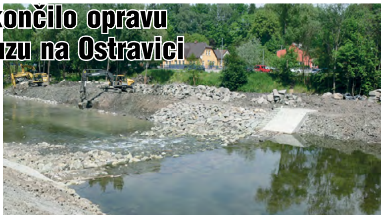
Ostravice, balvanitý stupeň ř. km 35,957 – před dokončením.
