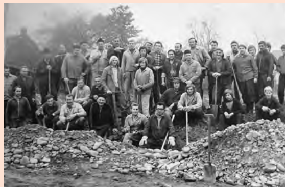
Archivní snímek z 10. září 1977 zachycuje více než tři desítky baštanských občanů, kteří se zúčastnili prvních výkopových prací pro stavbu nové mateřské školy v Bašce.
