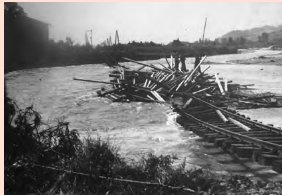
Před 75 lety v červenci roku 1941 postihla Bašku jedna z největších povodní v její historii. Na archivní fotografii Rudolfa Blahuta je zachycena rozvodněná Ostravice. Po několika týdnech nebyla v provozu železniční stanice v Bašce, která byla povodní těžce poškozena.
