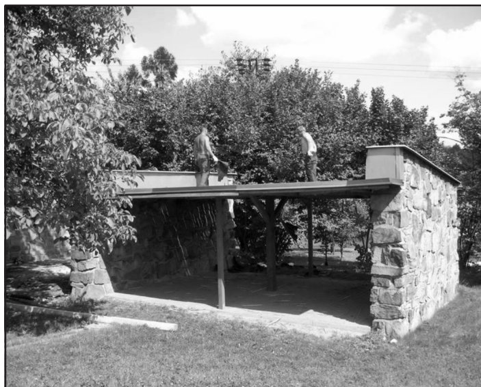
Stavba venkovního posezení v mateřské škole
