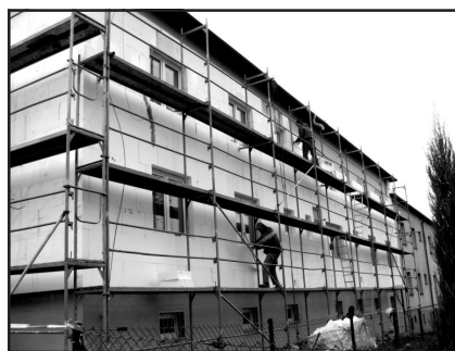
Zateplení domu na Panské
