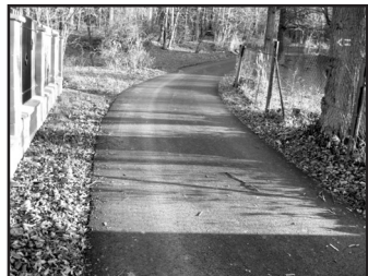
Ulice Rajska po opravě povrchu
