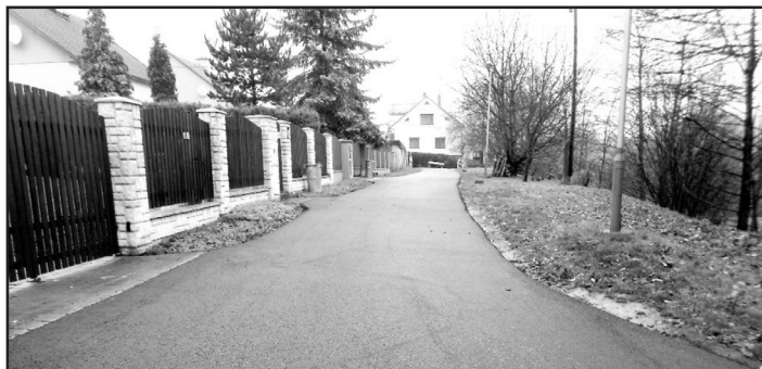
Opravená ulice Lesní
