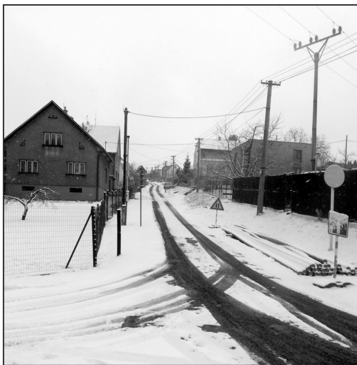
Opravy vodovodního řádu na ulici Petřvaldská FOTO M. POLOKOVÁ
