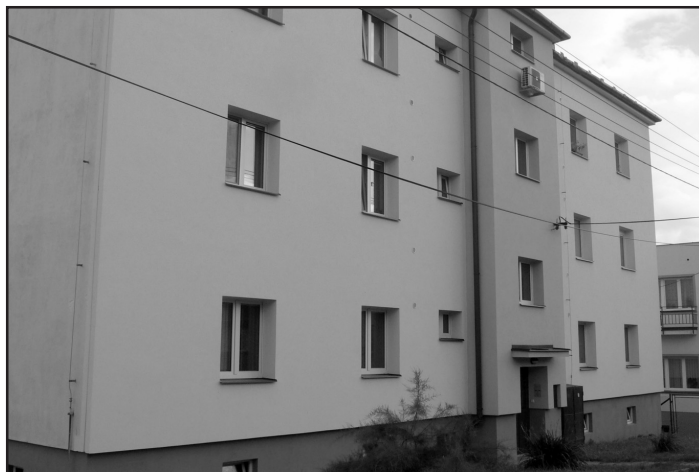
Zateplený a opravený dům na Bláhově ulici
