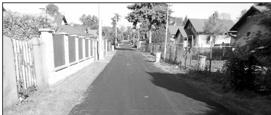
Ferdinandská ulice po opravě
