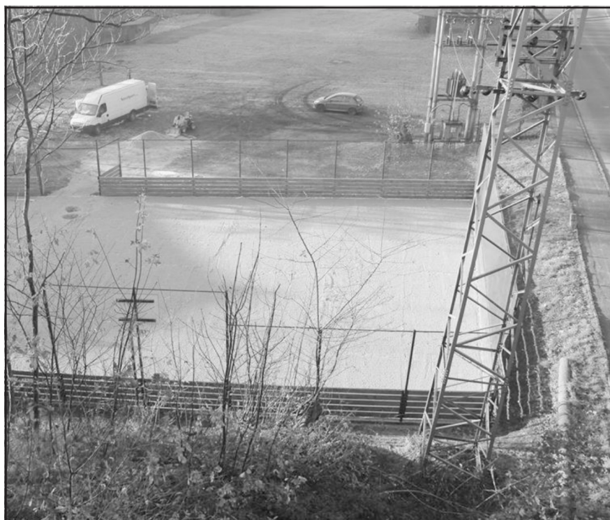
Víceúčelové hřiště u hasičské zbrojnice
