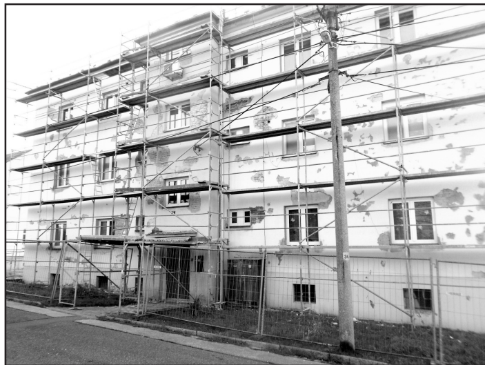
Zateplování domu na ulici Bláhově
