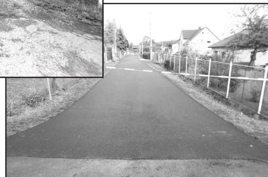
Ulice Na Věterce před a po opravě
