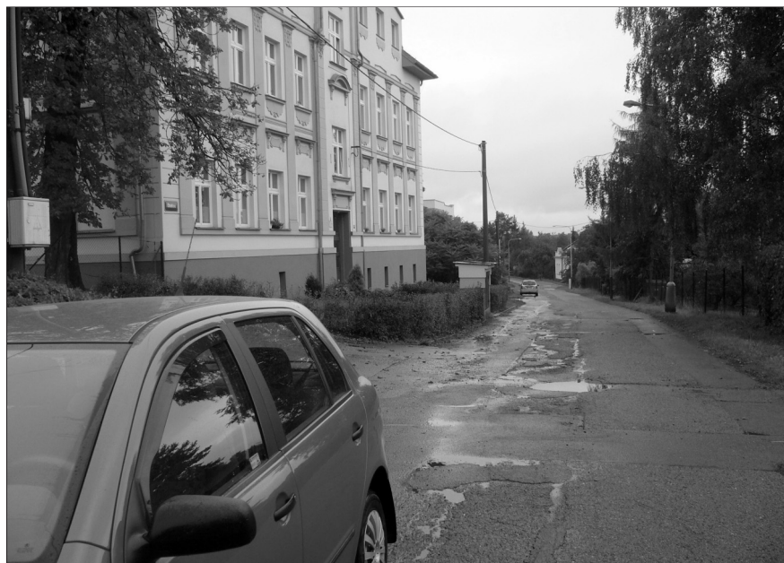
Ulice Čihálkova se také brzy dočká celkové opravy vozovky
