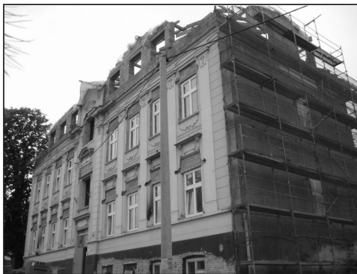
Současná přestavba školy na bytový objekt
