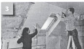
Opláštění vodorovných a šikmých stěn sádrokartonovými (či sádrovláknitými) deskami
