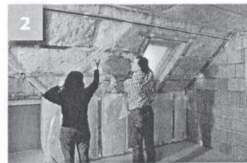
Aplikace parozábrany pod již vloženou tepelnou izolaci
