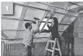
Přípevnění pozinkovaných profilů a krokrových závěsů
