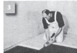
Nanesení PUR lepidla
