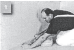
Připevnění okrajových pásků
