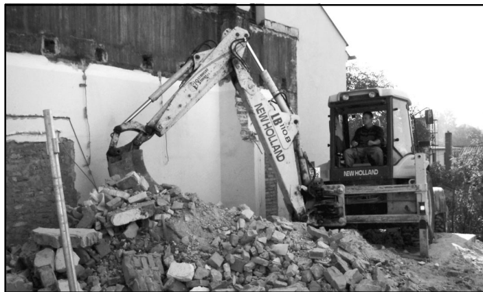
Práce na rekonstrukci obecního úřadu se rozjely naplno.
