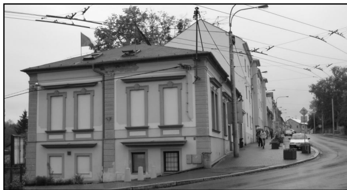
Do konce 1. pololetí příštího roku bude objekt ÚMOB rekonstruován. FOTO P. POLOK
