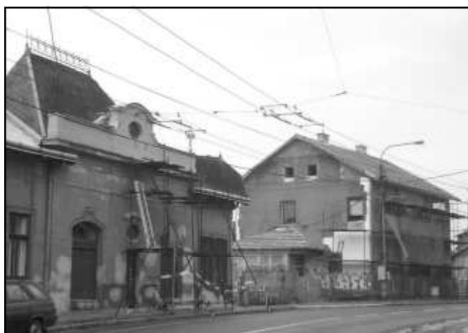
I když je letní, prázdninové období, naši spoluobčané zkrášlují své domy. Takto se pracuje na ulici Čs. armády, na které přibýly další opravené objekty.
