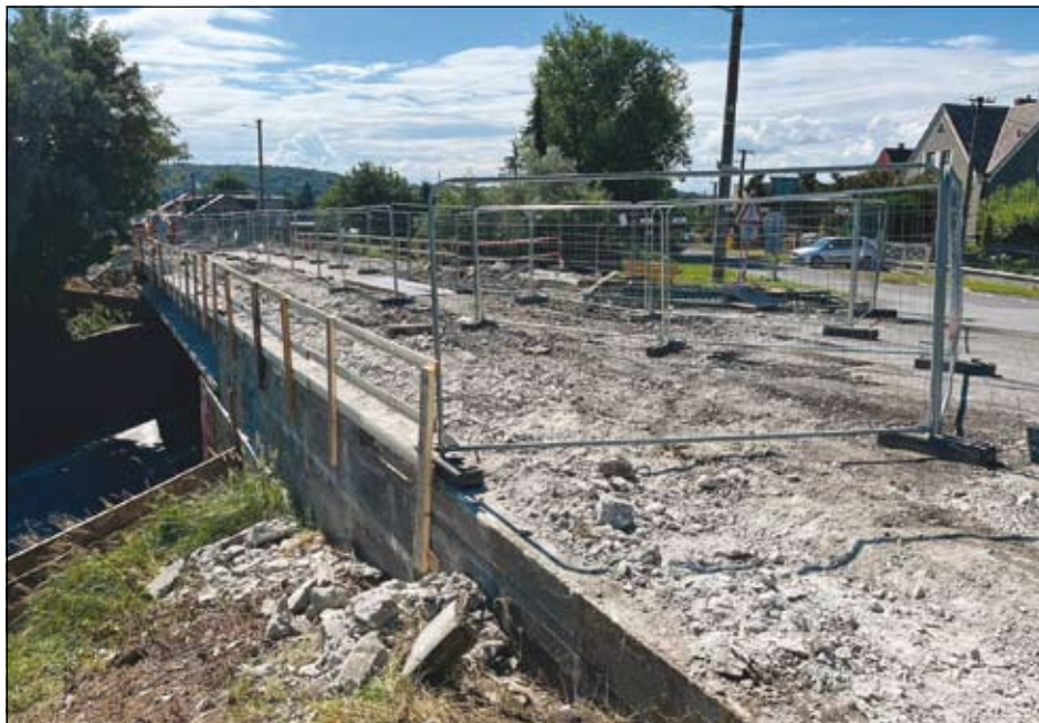
foto z 11. července – rekonstrukce mostu na Vrablovecké ulici
